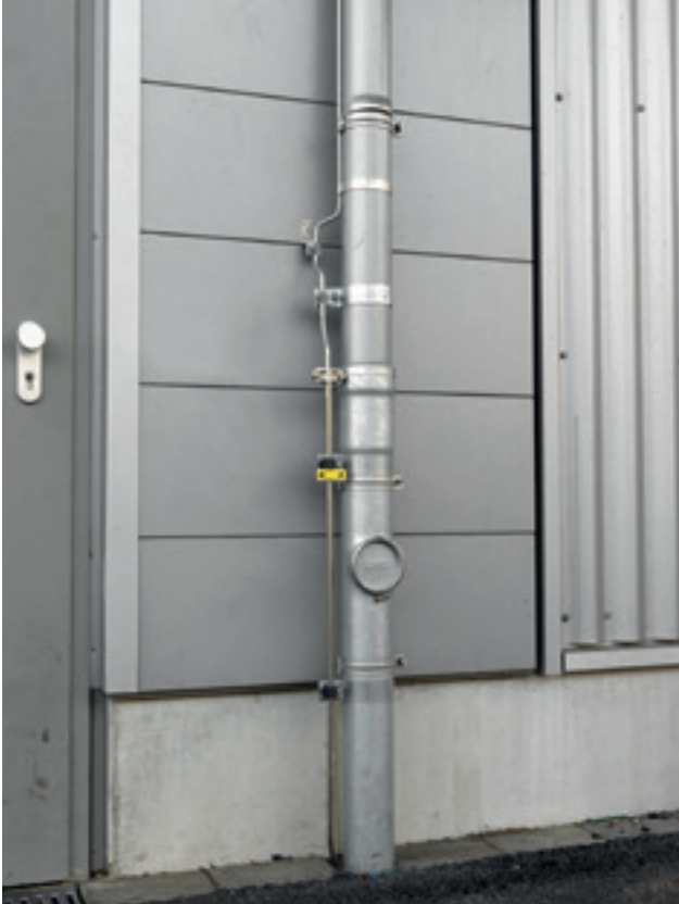
Alastulojohdin syöksytorvessa
