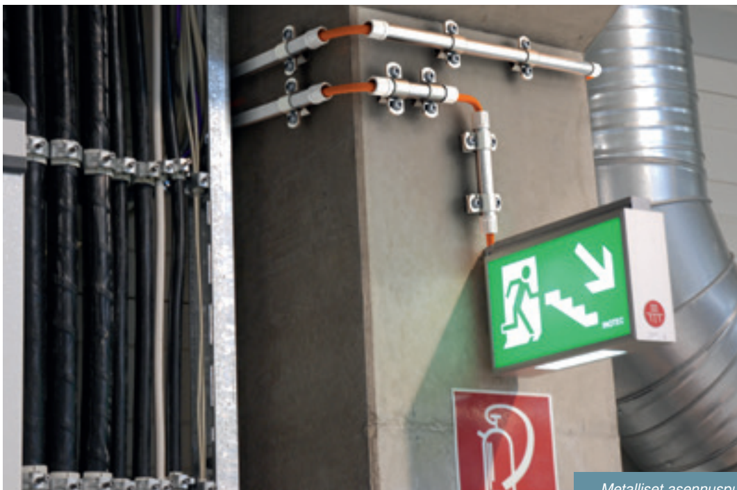
Metalliset asennusputket: paras valinta asennusten suojaamiseen ankarissa olosuhteissa
